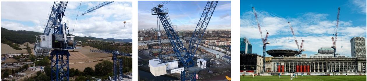
Todas las grúas abatibles del Grupo cuentan con variación de frecuencia en los mecanismos de giro, elevación y abatimiento para asegurar movimientos suaves y seguros.
